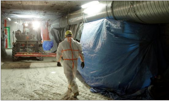
Un système d'aération, avec filtration des fumées et mesure des émissions, a été installé dans les blocs où sont reconditionnés les déchets.
