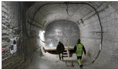
Le chantier pilote des barrages a permis de constater une plus grande perméabilité et résistance de la technique du béton coulé par rapport au béton projeté. Photo L'Alsace
