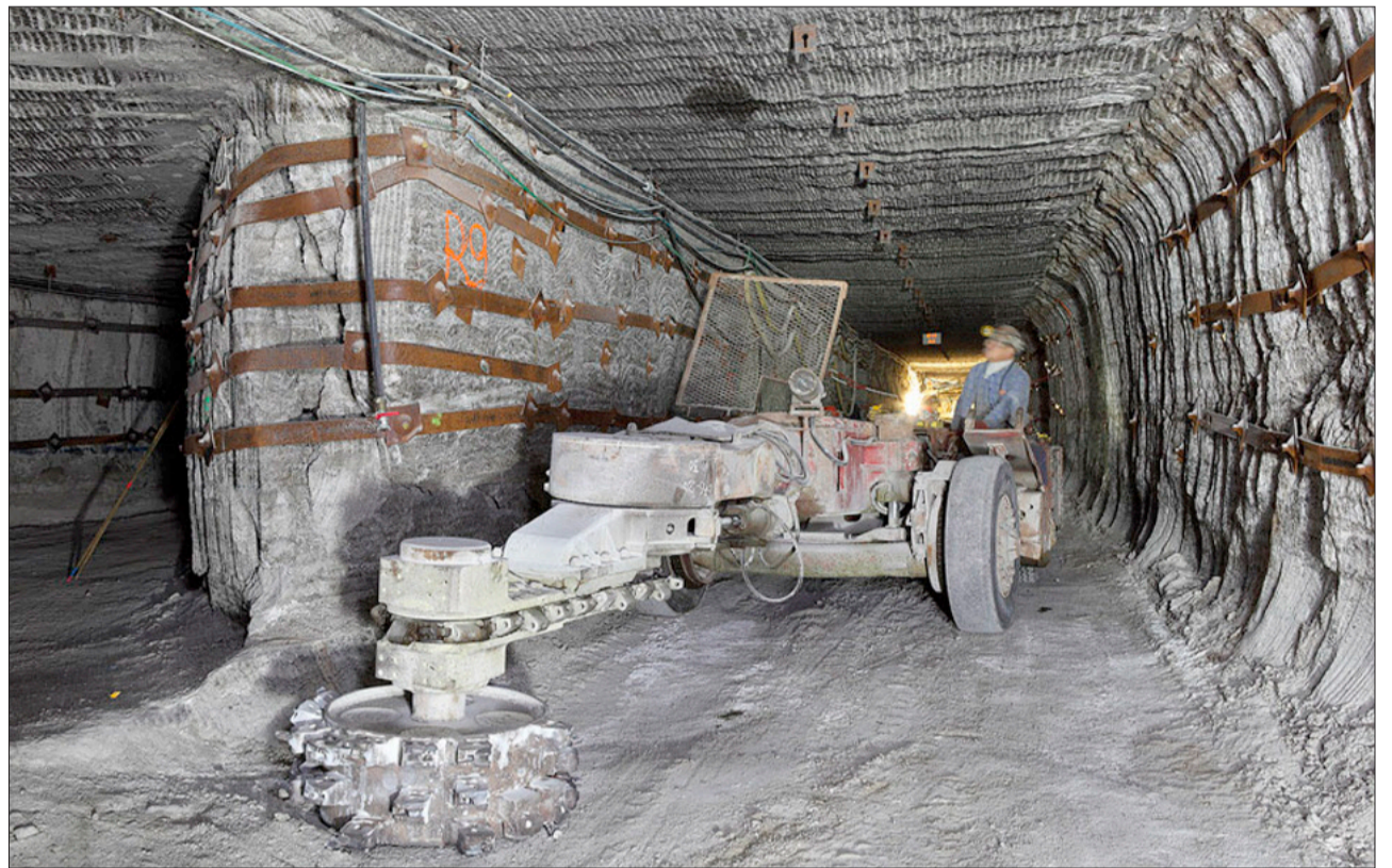
Die Hohlräume werden enger, das Wasser kommt näher: ehemaliges Kalibergwerk im Elsass FOTOS: THIERRY GACHON
