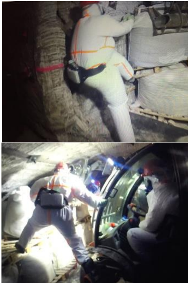
Figure 4 : Conditions dangereuses d'extraction manuelle des colis liées aux outils utilisés lors de la récupération des déchets mercuriels [Rapport ROV CONSULT, 2016].
