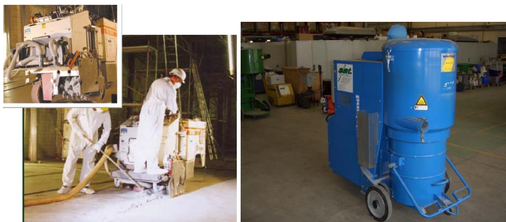
Figure 11 : Décapage des surfaces avec aspiration des poussières (gauche) ou utilisation d'un aspirateur industriel (droite).
