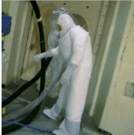
Figure 6 : Exemple de combinaison intégrale reliée à un cordon d'alimentation en air frais.
